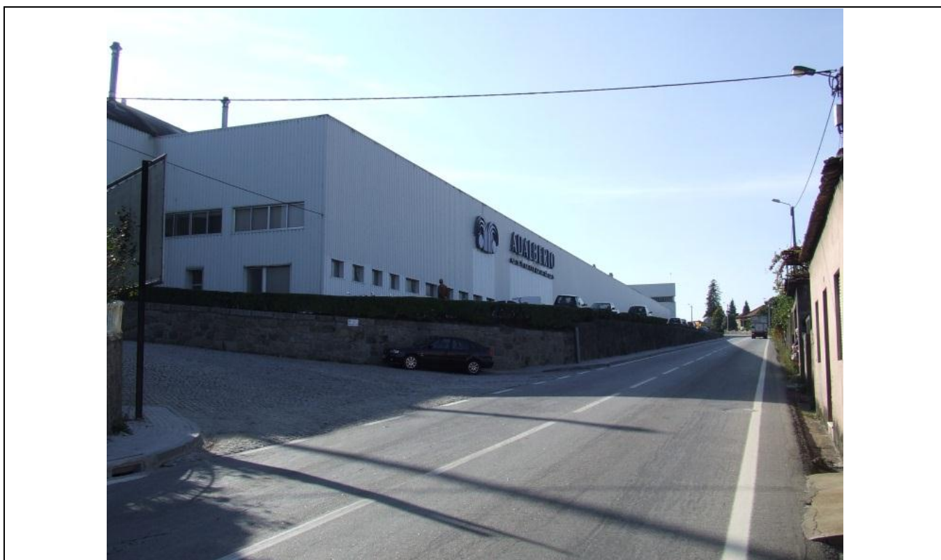
Figura 4: Frente do Projeto que confina com a estrada nacional
