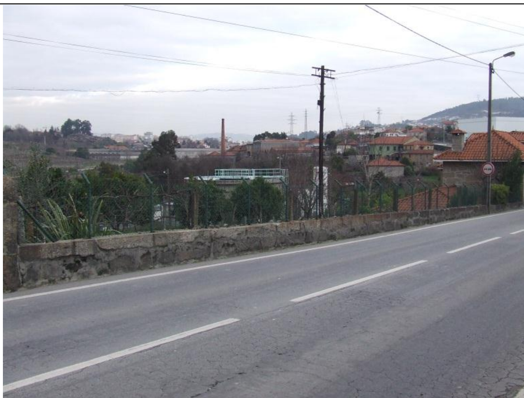
Figura 6: Frente da ETAR do Projecto que confina com a estrada nacional
