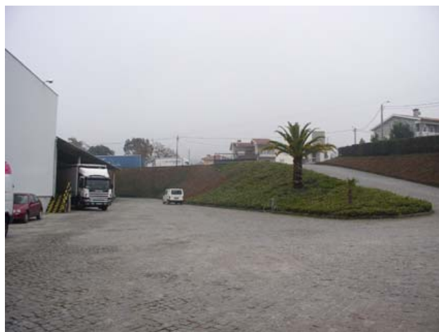
Fig. 3 – Aspecto das instalações
