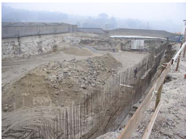
Fig 5 – Área em construção: vista geral
